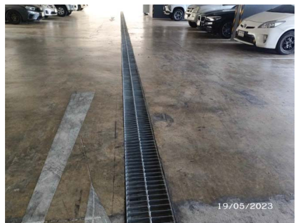
รูปที่ 2-54 ตะแกรงครอบท่อระบายน้ำ
