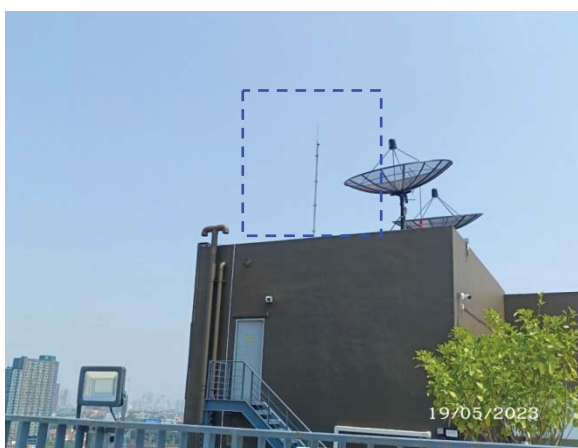
รูปที่ 2-26 ระบบป้องกันฟ้าผ่า
