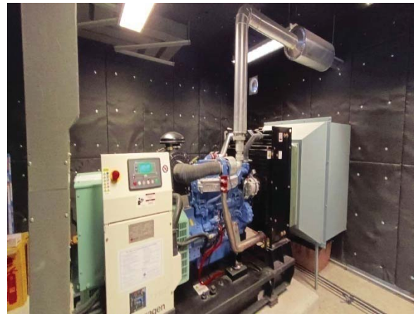
รูปที่ 2-47 เครื่องสำรองไฟฟ้า
