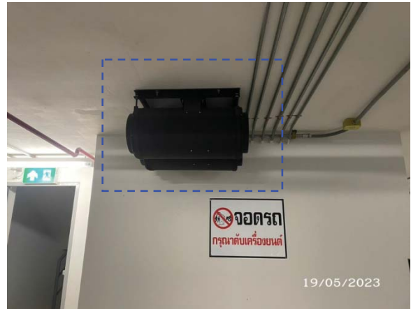
รูปที่ 2-51 พัดลมระบายอากาศ บริเวณที่จอดรถชั้นใต้ดิน
