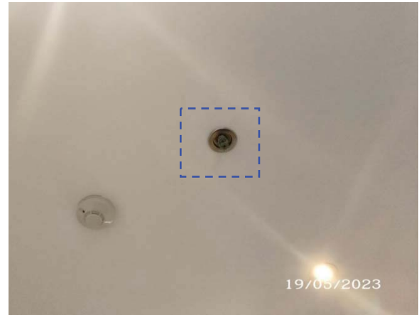
หัวกระจายน้ำดับเพลิงอัตโนมัติ (Sprinkler Head)
