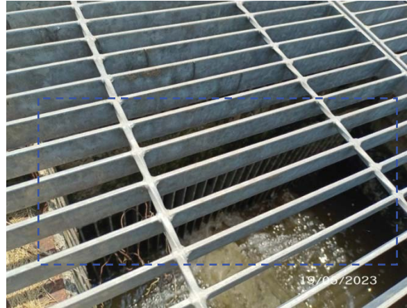
รูปที่ 2-18 ตะแกรงดักขยะ
