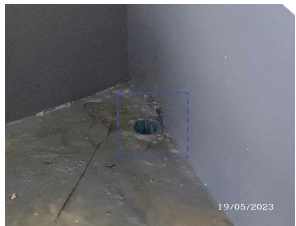
รูปที่ 2-25 ท่อรวบรวมน้ำเสียภายในห้องพักมูลฝอย
