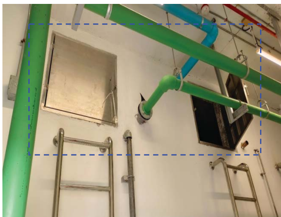
รูปที่ 2-15 ถังสำรองน้ำชั้นใต้ดินแบบ 2 ฝา/ถัง
